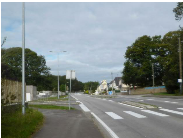
Photo 1 : Habitations le long de la rue de Tromeur (Nord)
