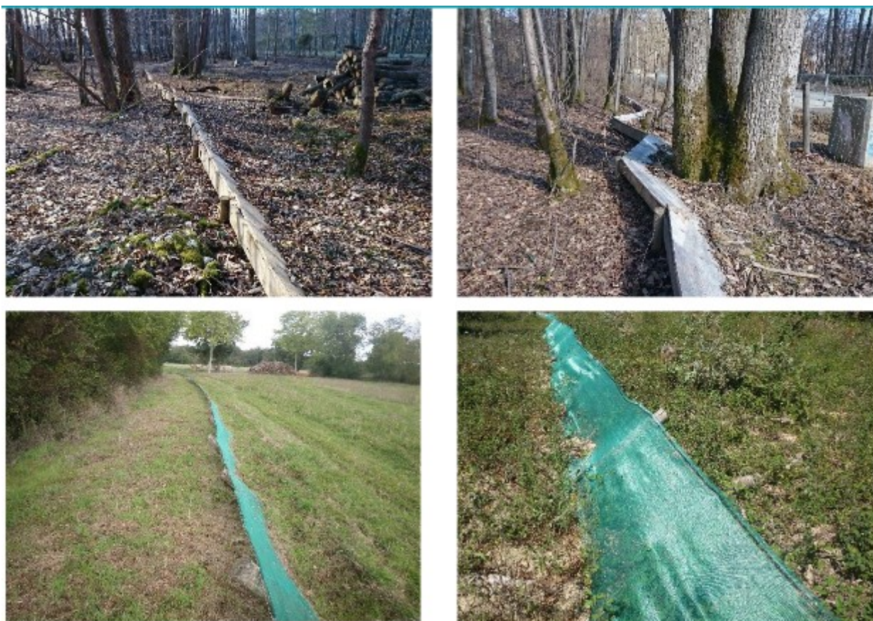
Illustration 134: Exemple de barrière semi-perméable pour la petite faune (Source : Biotopie 2022)
