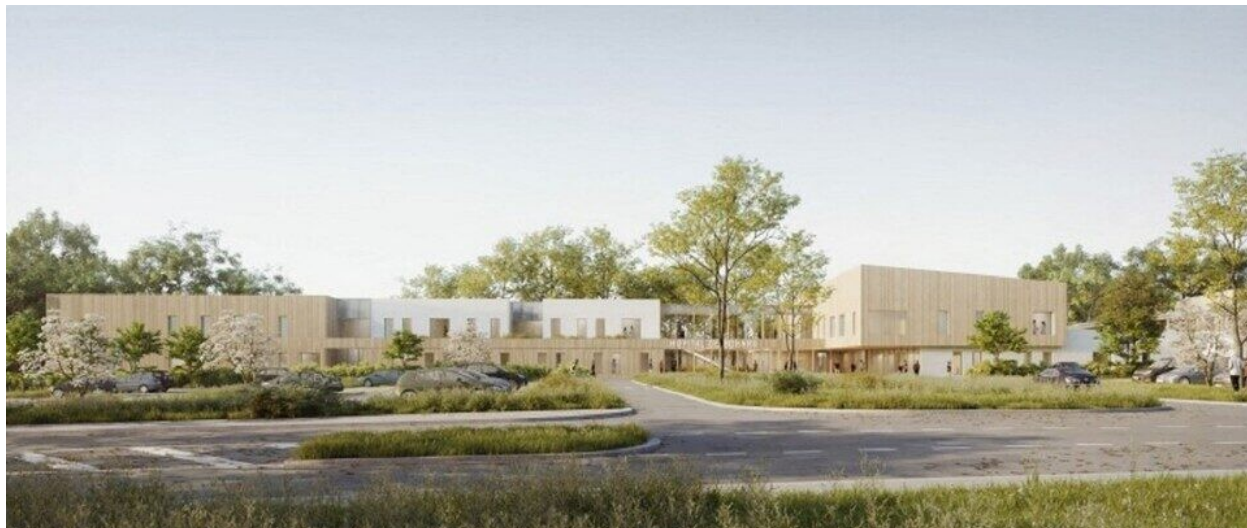
Illustration 114: Insertion paysagère du site depuis le Nord de la rue Tromeur (Source : APS, AIA, 10/11/22)
